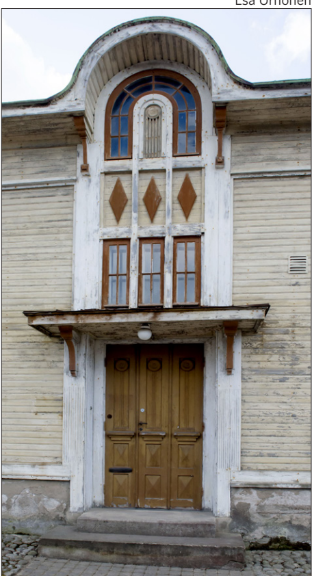
Vuonna 1920 valmistuneessa hirsitalossa on paljon yksityiskohtia.
